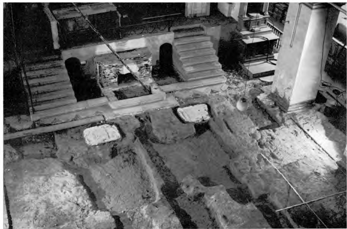
Abb. 1: Iilmünster, St. Arsadius. Blick auf die Grabung im Mittelschiff. Vor den Chortreppen Fundamente des ehemaligen Lettners mit Abdrücken sekundär verwendeter Flechtbandplatten.
