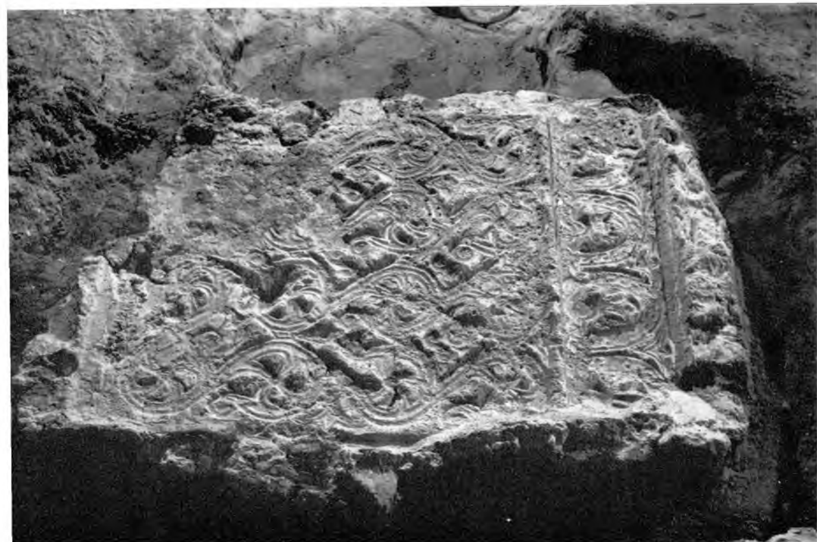
Abb. 4: Iimmünster, St. Arsadius. Südliches Lettnerfundament des 13. Jh mit Abdruck einer ehemaligen Chorschrankenplatte.
