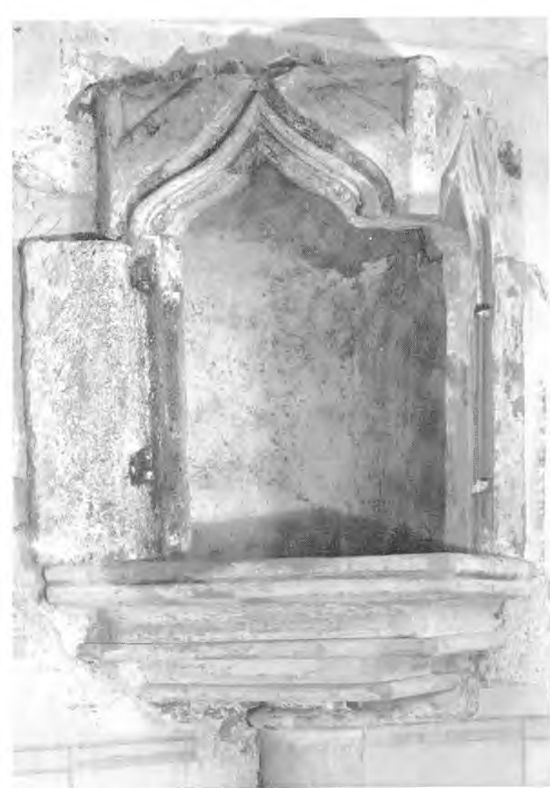
Abb. 1: Sakramentshaus von St. Wolfgang im Zustand der Zerstörung
