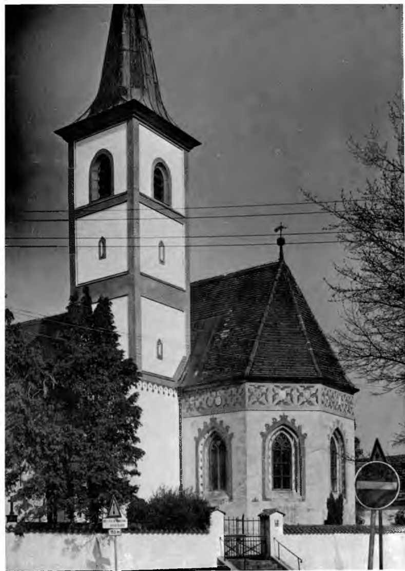
Abb. 3: Turm der St. Wolfgangskirche im restaurierten Zustand von 1979
